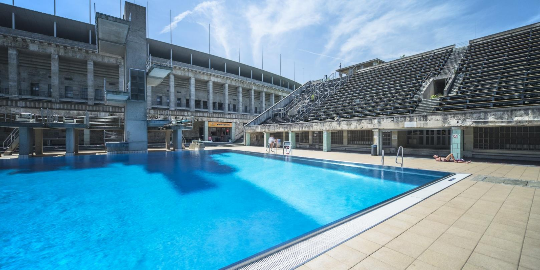
Sanierung Olympiabad Berlin
